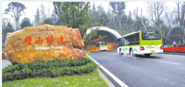
璧山一大学城隧道
