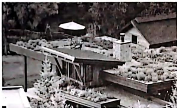
图 9-38 错落设置的屋顶花园
