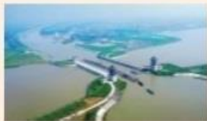
图5-3 淮安枢纽工程
