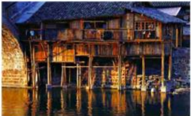
传统木结构民居湘西吊脚楼
