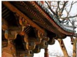
古建筑上的斗拱
