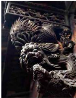
浙江东阳民居廊檐下的撑拱 明
