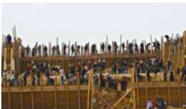
传统夯土建造技艺
