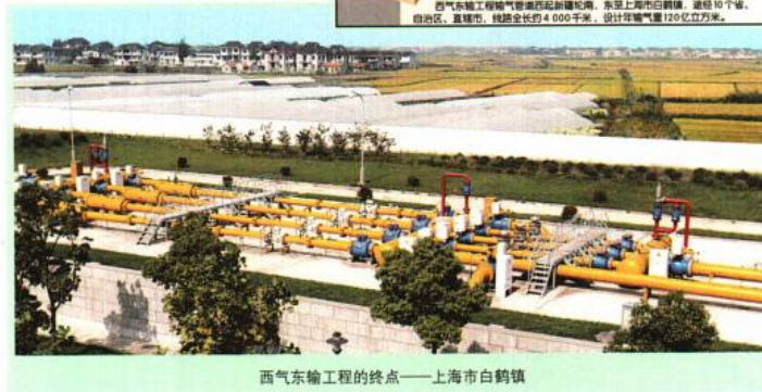
西气东输工程的终点——上海市白鹤镇
