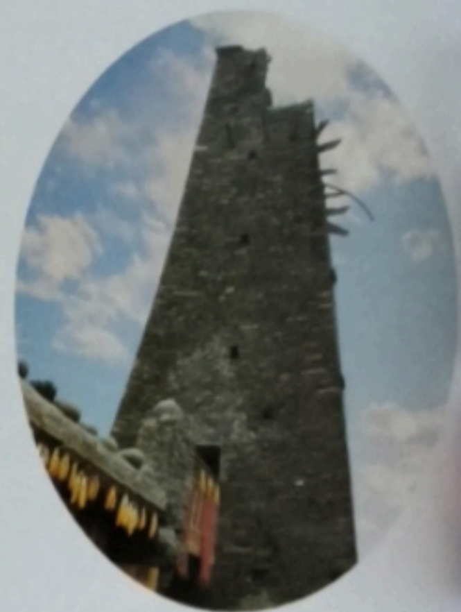
四川羌寨碉楼
