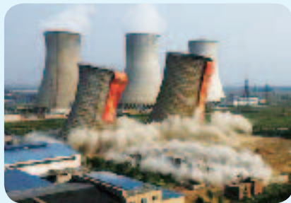
图2-14 拆除小火电站
