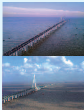
图1-3 杭州湾跨海大桥
