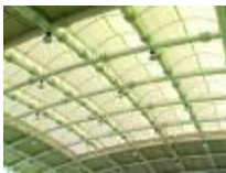
图 5.31 屋顶采用阳光薄膜等新材料大量引进自然光
