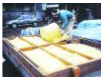
图 5.30 地板下也填满了隔热材料
