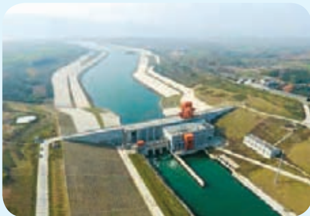
图1-6 南水北调工程
