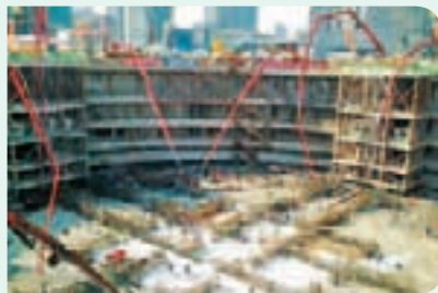
图1-2 上海中心大厦地基浇筑
