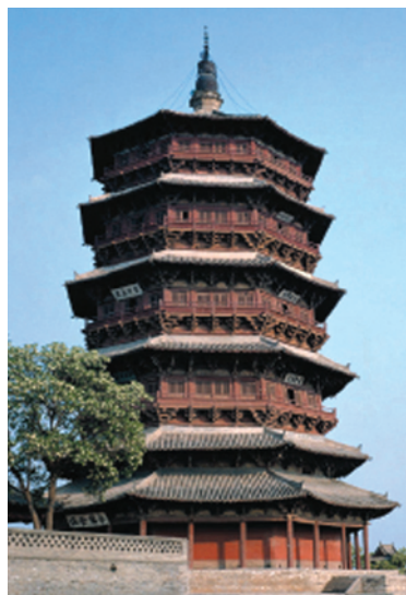
图 1.55 山西应县木塔
