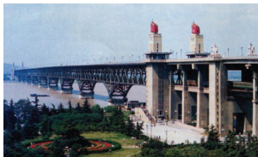
b. 桁架结构的桥梁
