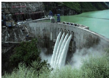
a. 锦屏混凝土双曲拱坝
