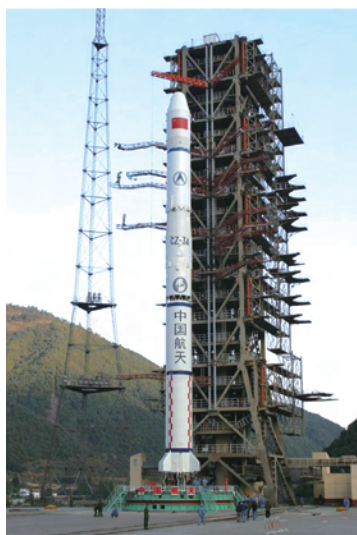
d. 桁架结构的卫星发射塔
