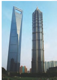
图3-87 建造楼房时必须考虑地基及建筑体所能承受的压强
