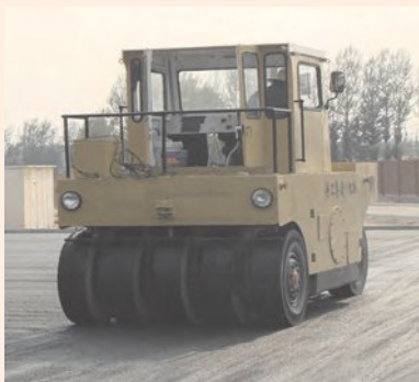
图3-18 压路机压路面
