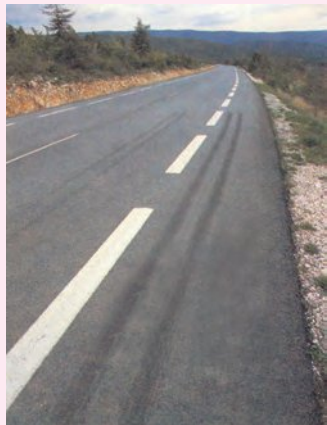
图3-61 从地上的刹车痕迹可以看出制动距离
