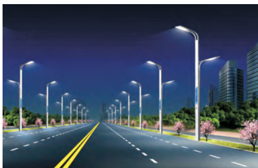
图 5-3-1 自动照明路灯
