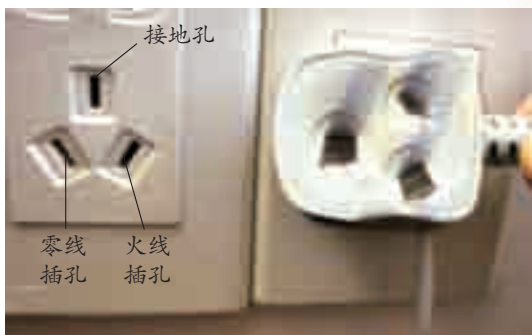
图1-67 三孔式插座和三脚插头
