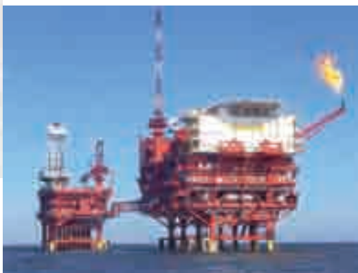
图3-27 油井边废气燃烧
