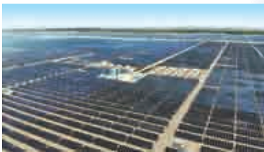
图3-94 格尔木光伏电站
