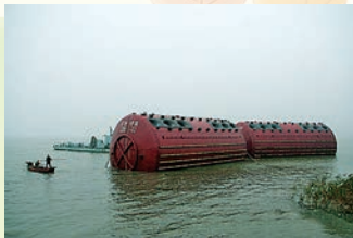
图3.2.9 正在进行打捞作业的浮筒
