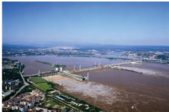
图 4.11 葛洲坝水利枢纽工程
