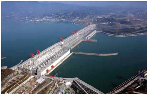
图 4.10 长江三峡水利枢纽工程
