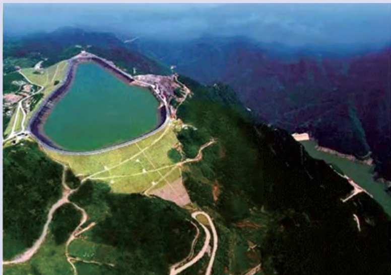
图 5-3-2 浙江省安吉县天荒坪抽水蓄能电站
