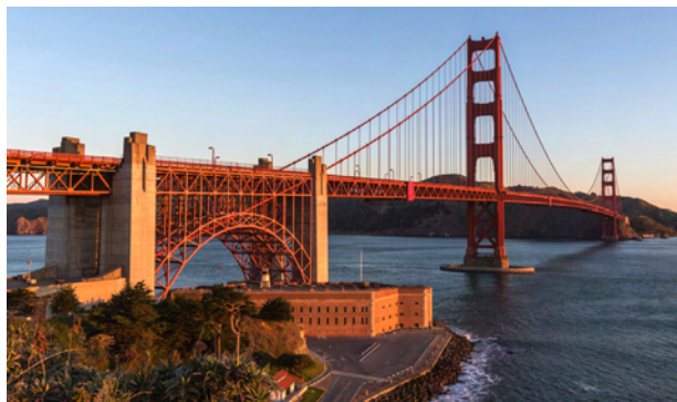
图 2.22 金门大桥（悬索桥）
