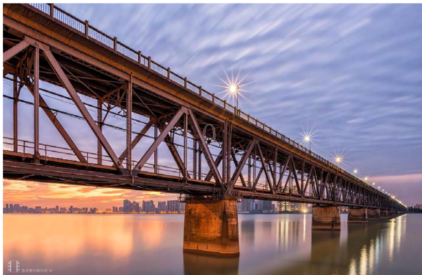
图 2.12 钱塘江大桥（梁式桥）
