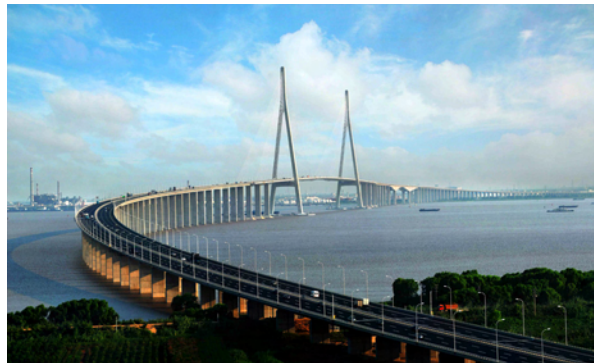
图 2.23 苏通大桥（斜拉桥）
