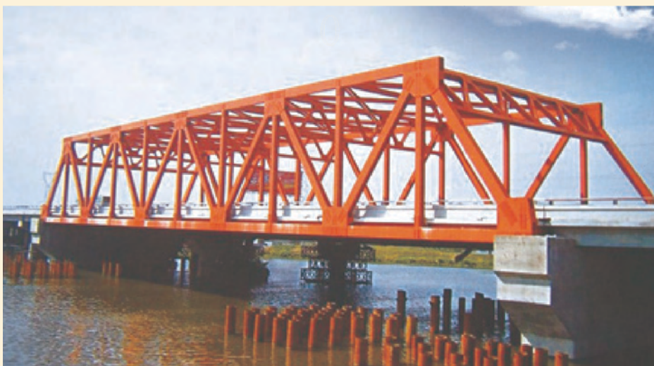
图 2.53 锡澄运河大桥
