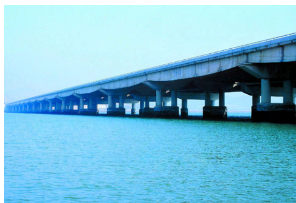
图 2.11 预应力钢筋混凝土桥
