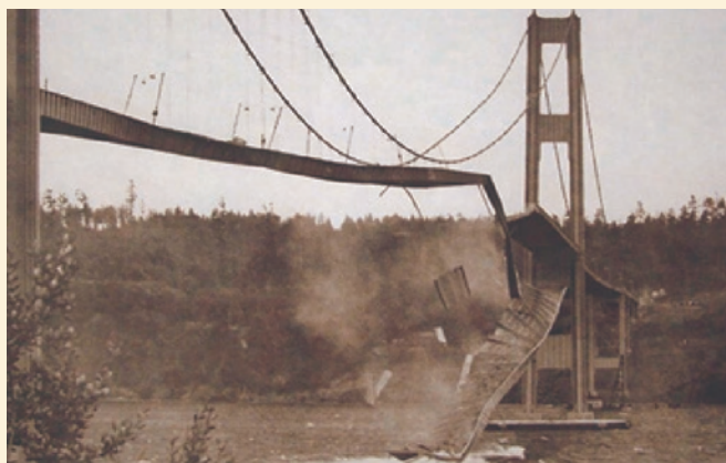
图 2.55 塔科马海峡大桥
