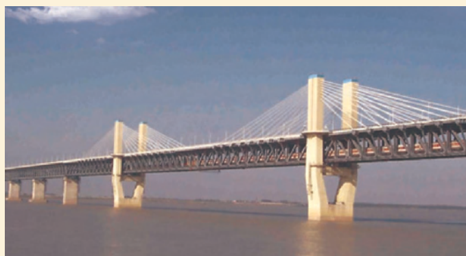
图 2.51 芜湖长江大桥
