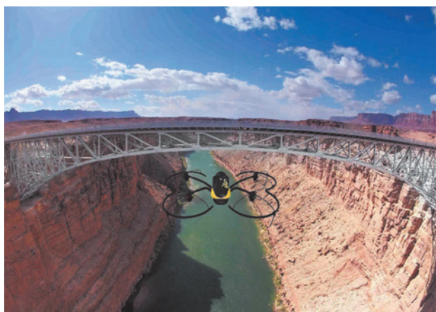
图 3.6 使用无人机进行桥梁检测
