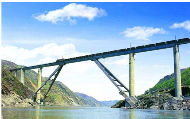
图 2.18 安康汉江铁路桥（刚架桥）
