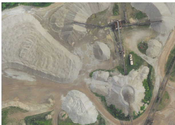
图 3.2 建筑工程施工过程中的土堆沙堆测量
