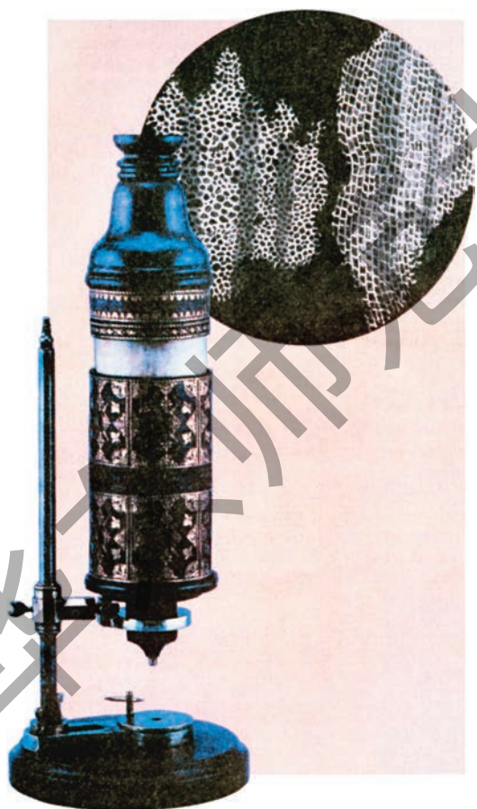
图 4.2.1 胡克制造的显微镜和他发现的细胞
