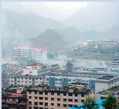
图6.1.8 地震后的北川县城
