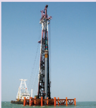
图3-26 钢管复合桩基础施工
