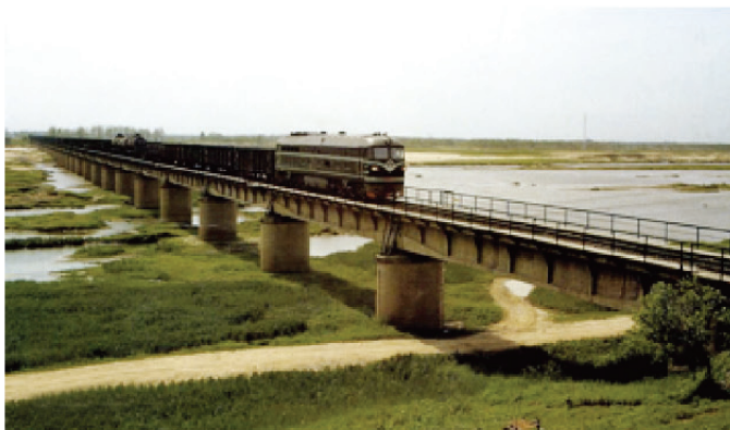
图3-5 山东新沂河桥——铁路简支梁桥
