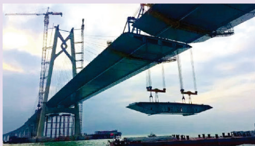
图3-29 主梁悬臂施工
