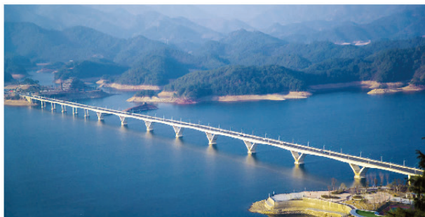
图3-7 千岛湖大桥——连续梁桥
