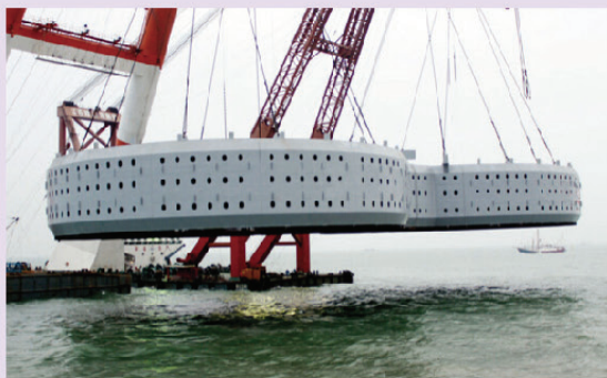
图3-27 大型主墩承台钢套箱整体吊装施工
