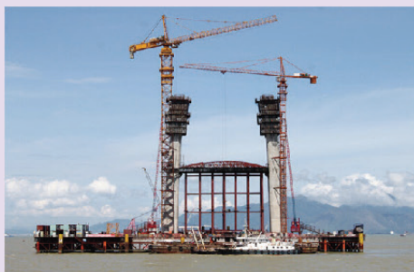
图3-28 主塔施工
