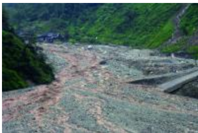
泥石流冲毁公路
