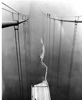
图2-5-5 美国塔科马海峡大桥由于被风驱动产生共振而使桥面剧烈扭动，最终断裂
