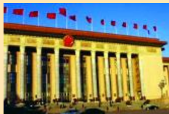
图 8.16 现代的钢筋混凝土建筑 ——人民大会堂
