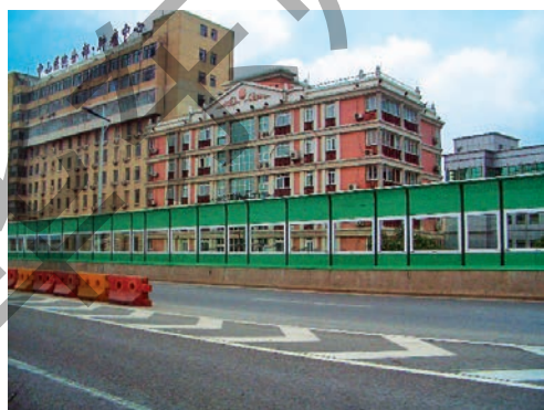
图1.3.4 高架道路旁的隔音板
