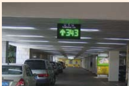
图2.1.9 车位引导系统中的引导屏
