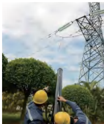
图2-1 用激光炮清除高压线上的异物
