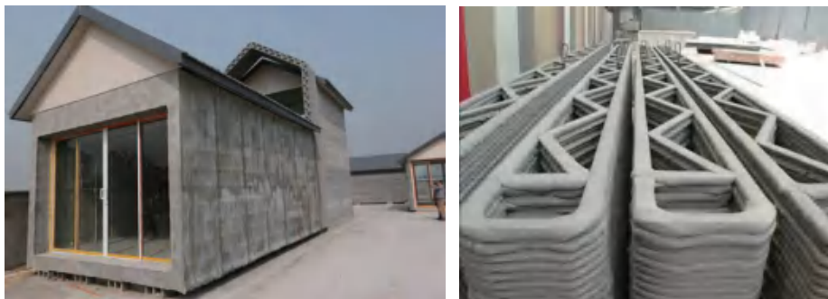
图4-53 三维打印制造房屋
