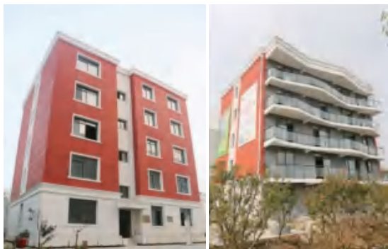
图1-3 三维打印的建筑
