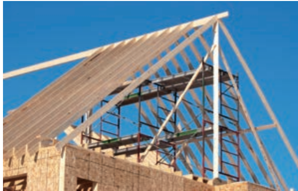
图 1-27 屋顶三角形桁架
