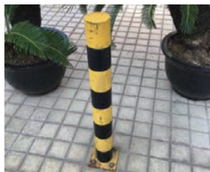
图1-33 安全桩与地面的螺栓连接
