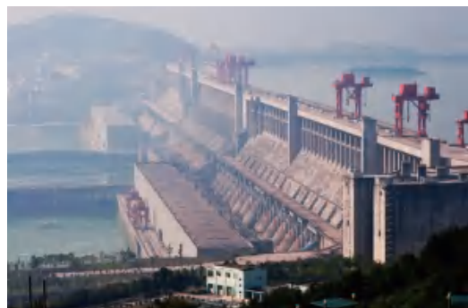
图1-29 混凝土重力坝
