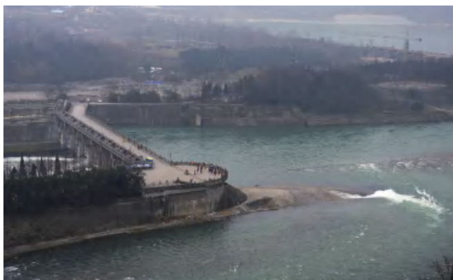
图3-13 都江堰鱼嘴分水堤工程
