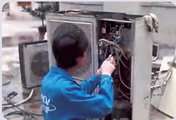
图4-25 检测空调室外机
