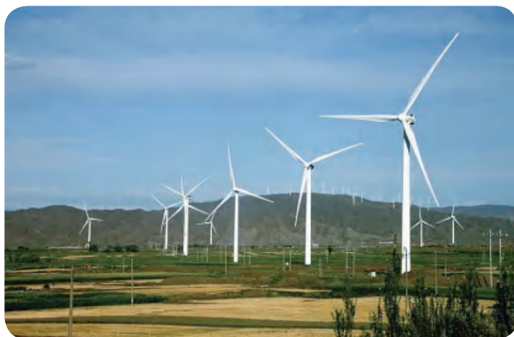
图2-7 大型风力发电厂
