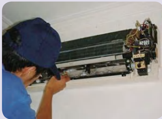
图4-26 检测空调室内机
