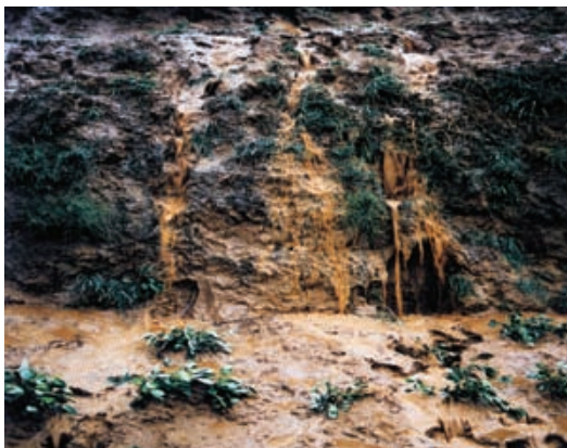
图 6.17 暴雨径流冲刷坡面
