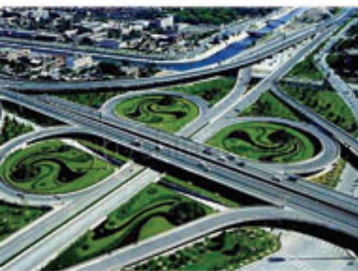
北京的立交桥
