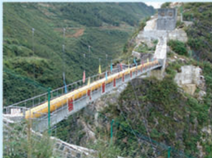
西气东输管道
