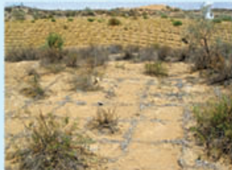
宁夏中卫县沙坡头采用草方格固沙
