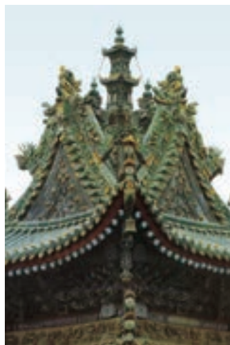
陕西某钟楼屋顶 明清
