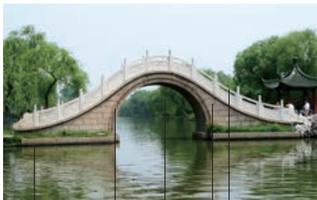
桥墩 桥拱 桥孔 桥身 桥栏
