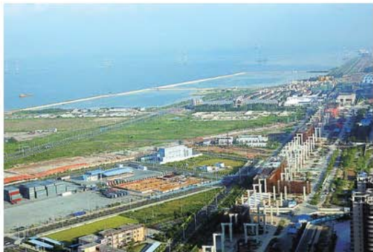
图 7-3-7 建设中的深港现代服务业合作区
