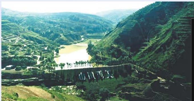
图 7-1-12 陕西省绥德县韭园沟流域骨干坝
