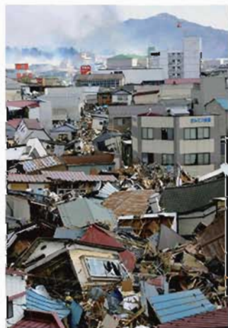
图 8-2-6 地震中倒塌的建筑物
