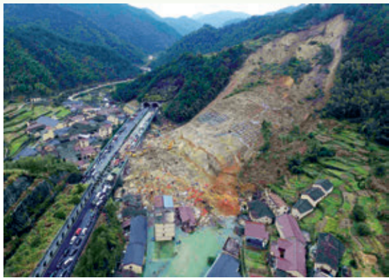
图 2-15 浙江丽水滑坡灾害现场
