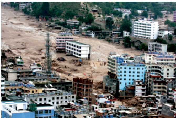
图 2-17 甘肃舟曲泥石流灾害现场
