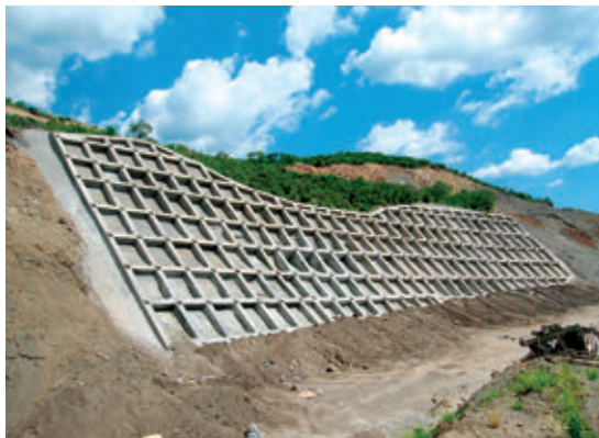
图 2-14 道路边坡加固
