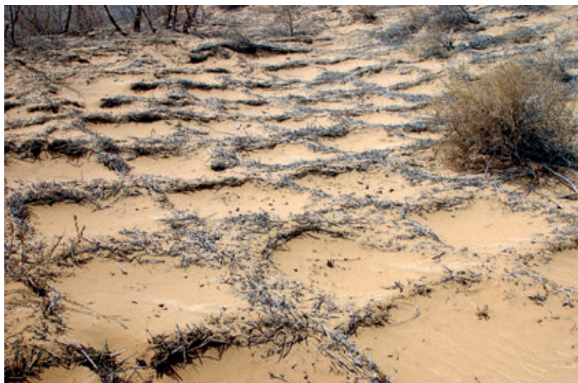
图 2-29 包兰铁路沙坡头段的草方格
