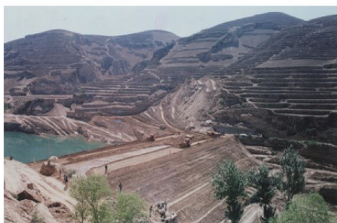
黄土高原水土流失治理——建淤地坝
