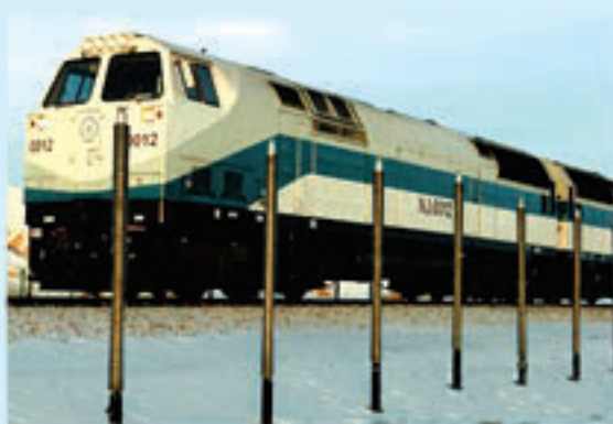
青藏铁路昆仑山口的冻土热棒区
