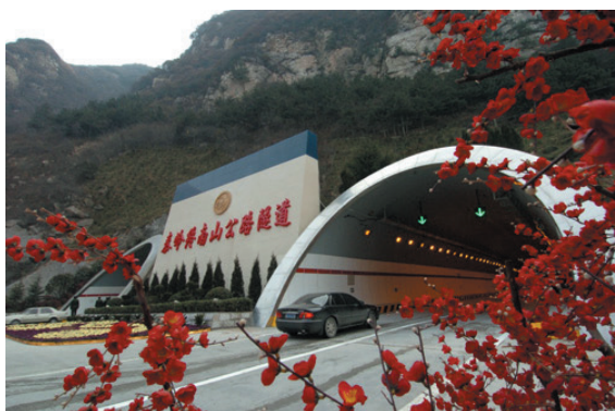
图7.73 贯通秦岭南北的终南山公路隧道
