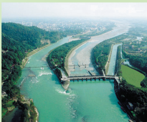
图7.41 都江堰水利工程
