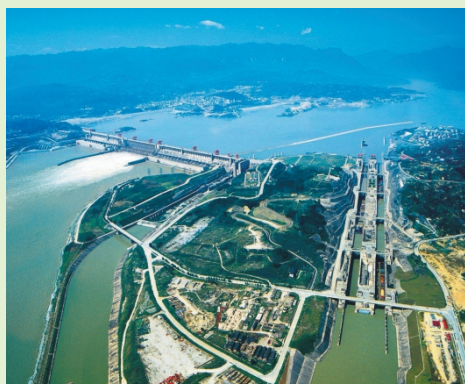
图7.24 三峡水利枢纽工程
