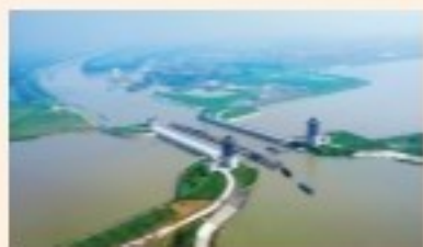
图5-3 淮安枢纽工程
