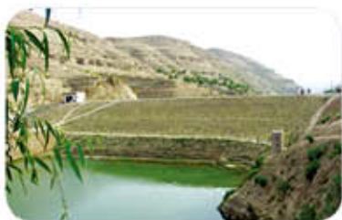
在沟谷兴修小型水库，打坝淤地和在坡面修建水平梯田等工程。
