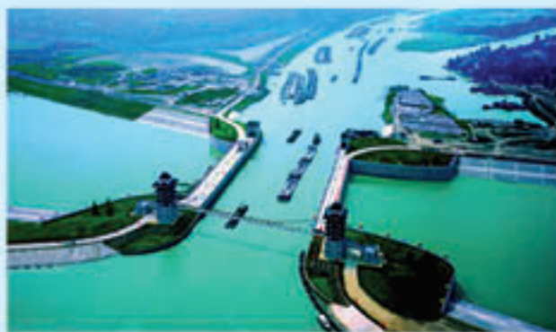
临淮岗水利枢纽工程
