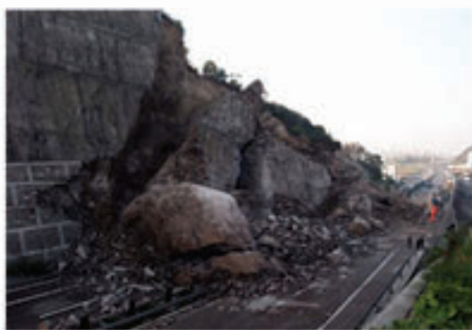
浙江甬台温高速公路柳市附近发生山体滑坡
