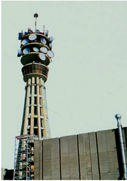
图 4-3-4 微波中继站（移动通信塔）
