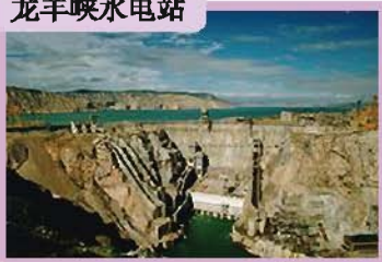
龙羊峡水电站
