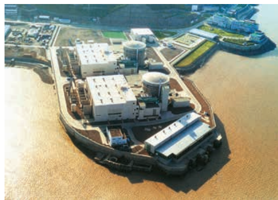
图 6-3-2 秦山核电站全景
