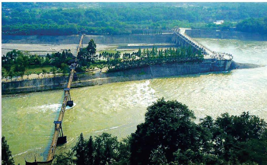
都江堰水利工程
