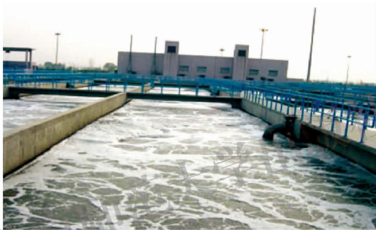
图 4-18 城市污水处理厂的好氧处理
