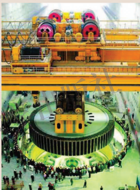
图14-57 吊装转子
