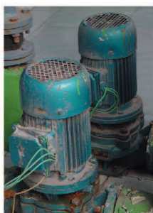
电动机外壳上的散热片
