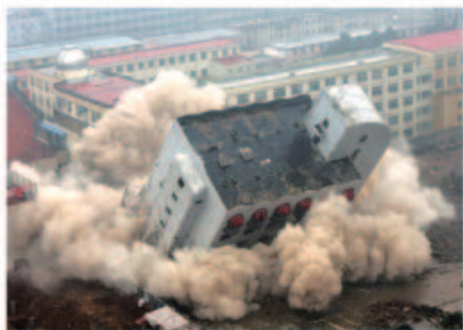
图7-17 利用炸药爆破拆除楼房
