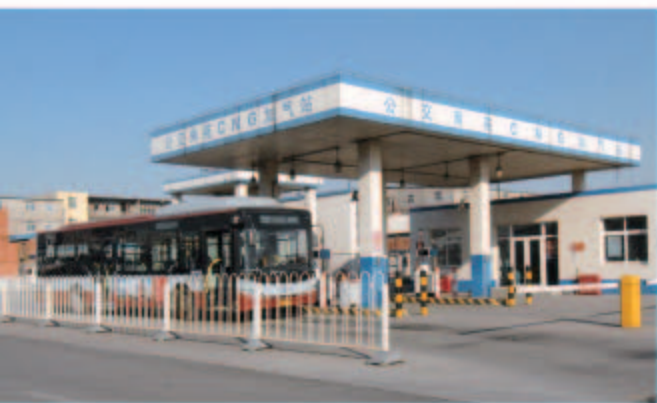
图7-38 压缩天然气汽车加气站
